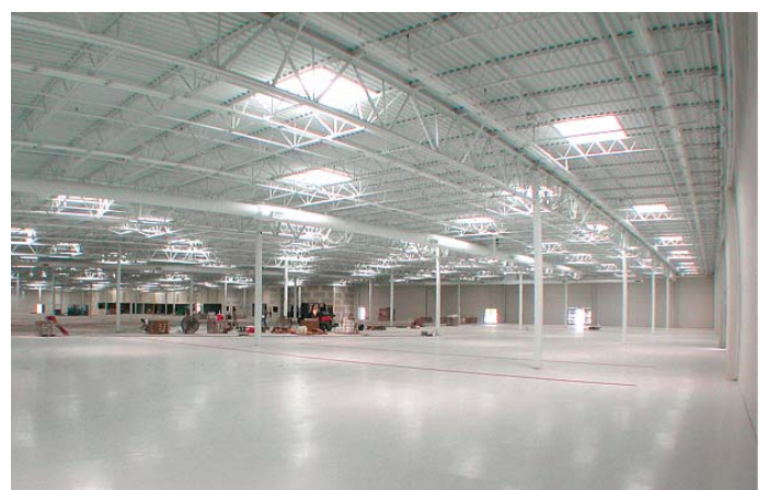
In großflächigen Industrie- oder Logistikhallen sorgen prismatische Lichtkuppeln für eine gleichmäßige und blendfreie Ausleuchtung
